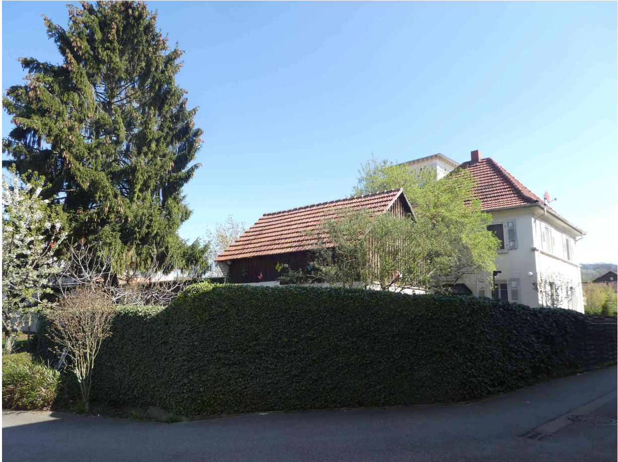
Abb. 5: Hildastraße 10, Ansicht des Anwesens von Südwest
